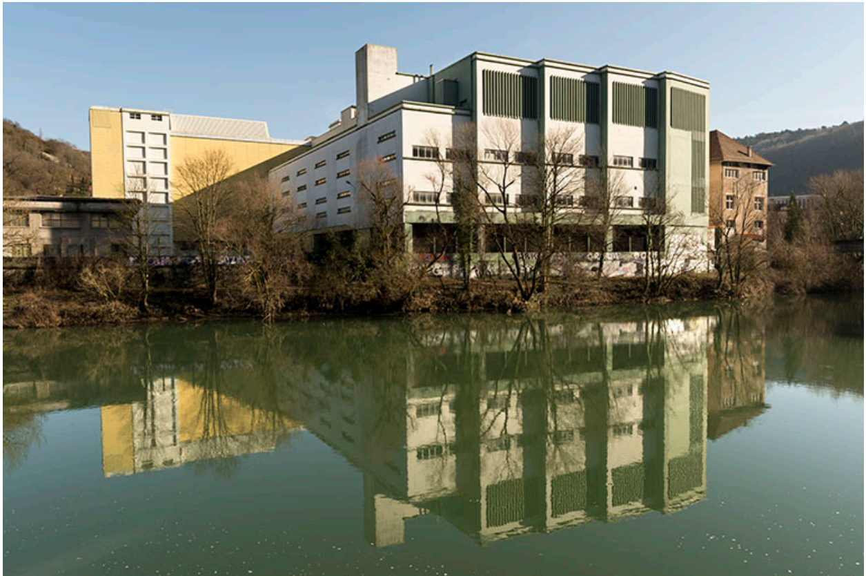
Etat en 2016. Usine B : façade sur le Doubs des ateliers d'étirage tergal et d'ourdissage, de trois quarts gauche.
