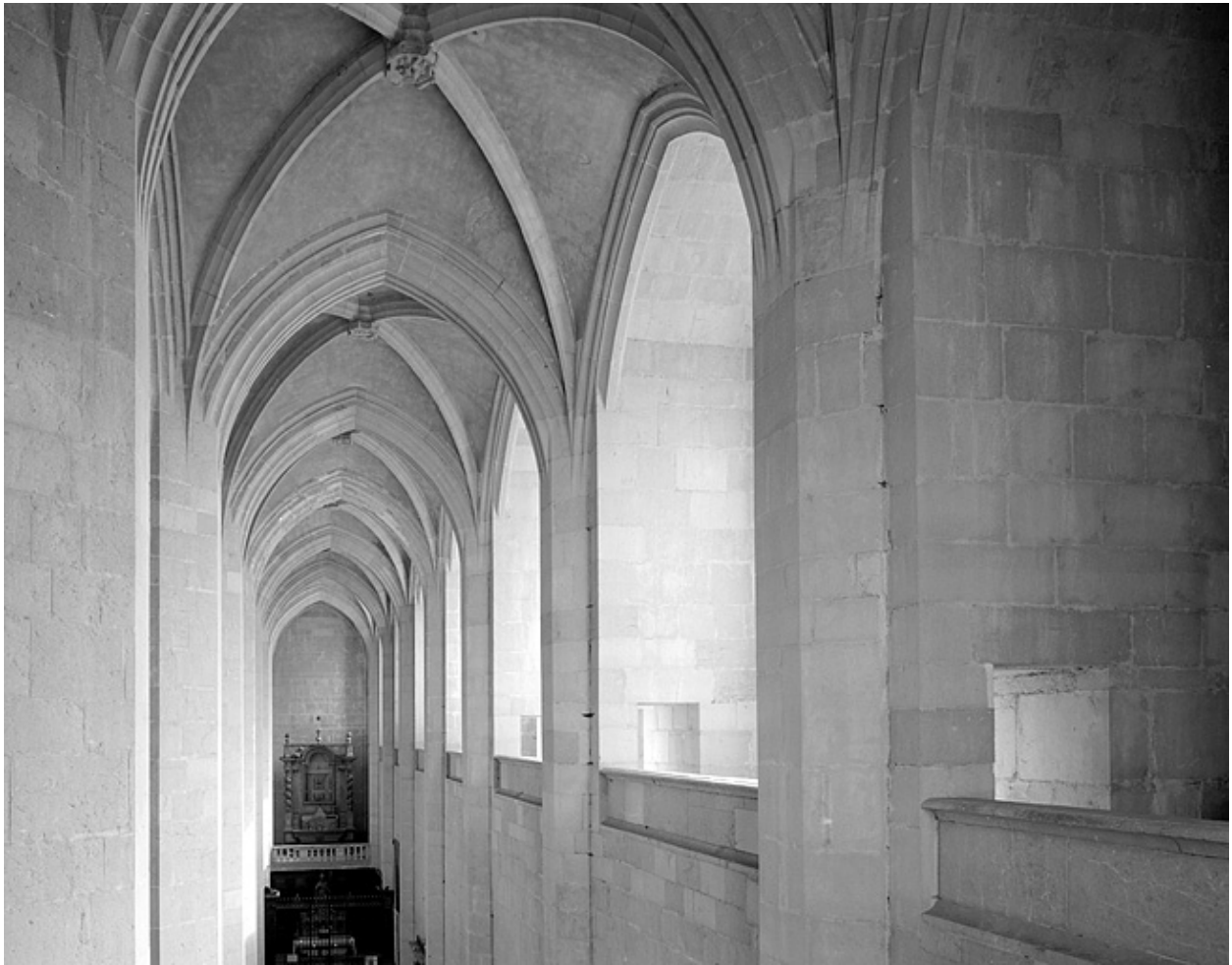
Vue latérale de la coursière du collatéral sud.
