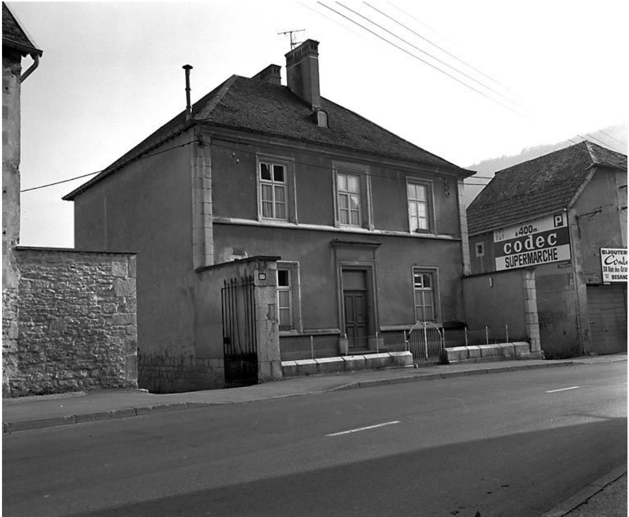
Maison située 28 rue Edouard Bastide.
