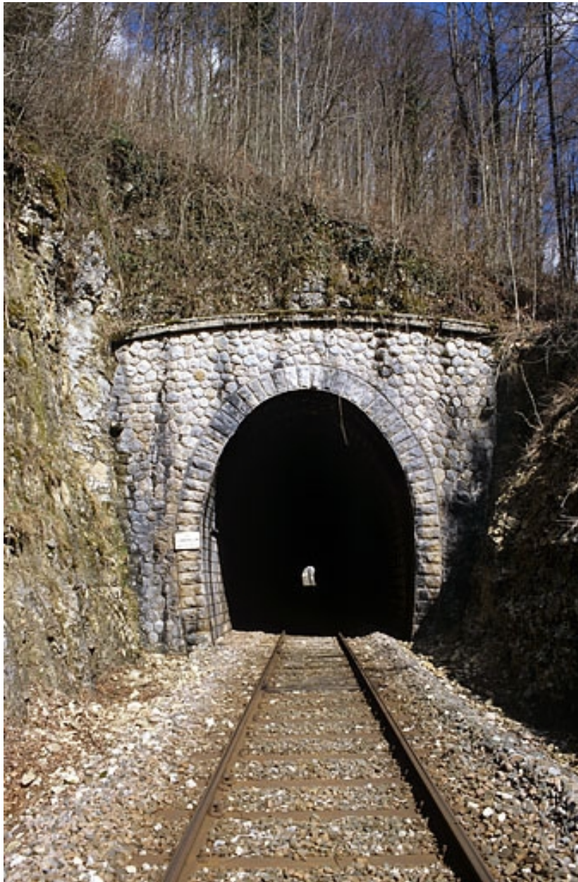
Tunnel du Grépillon : tête côté La Cluse (sud).
