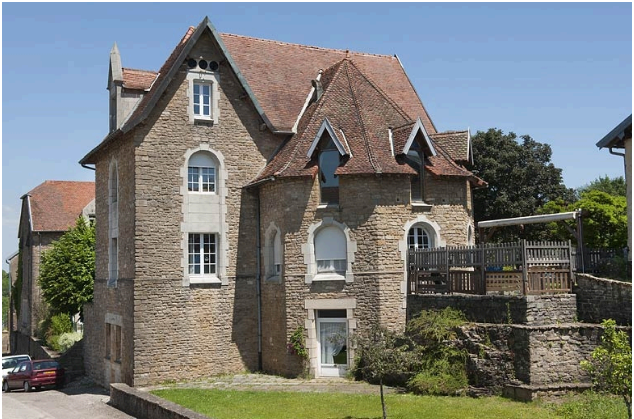
Bâtiment (G), vue rapprochée.
