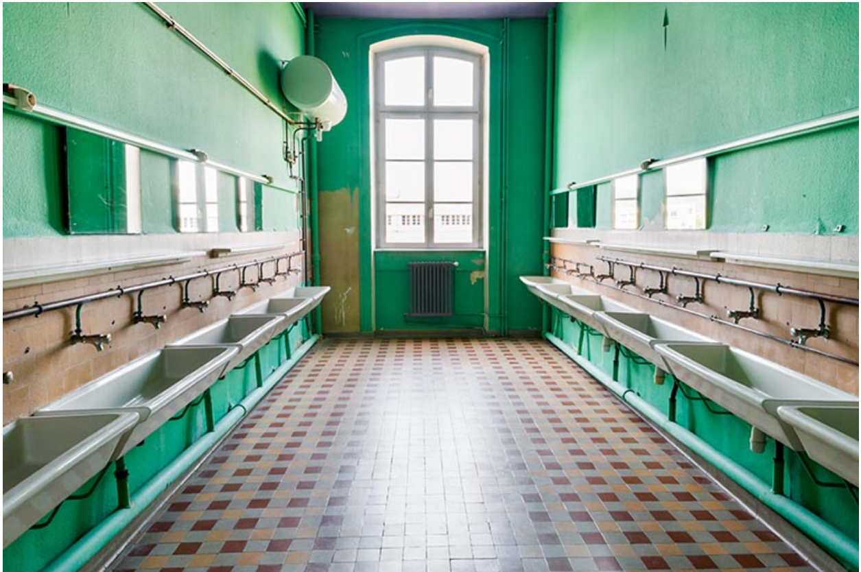
Lavabos à l'internat.
