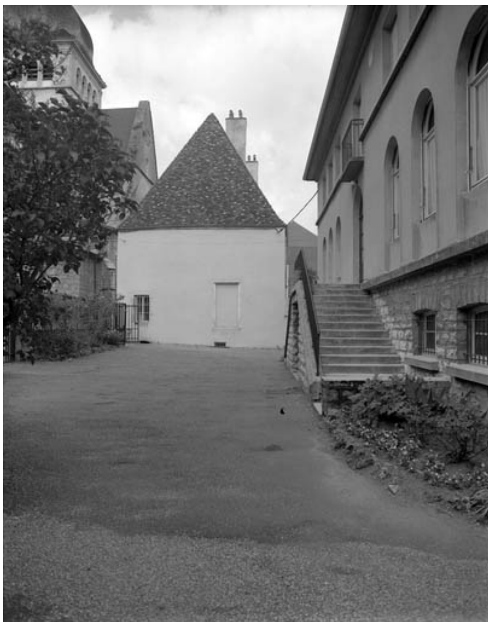
Façade latérale droite.
