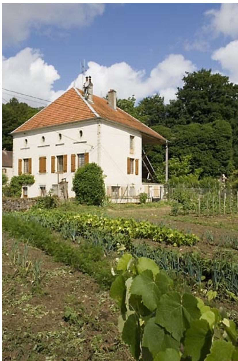
Logement patronal vu depuis le nord-est.
