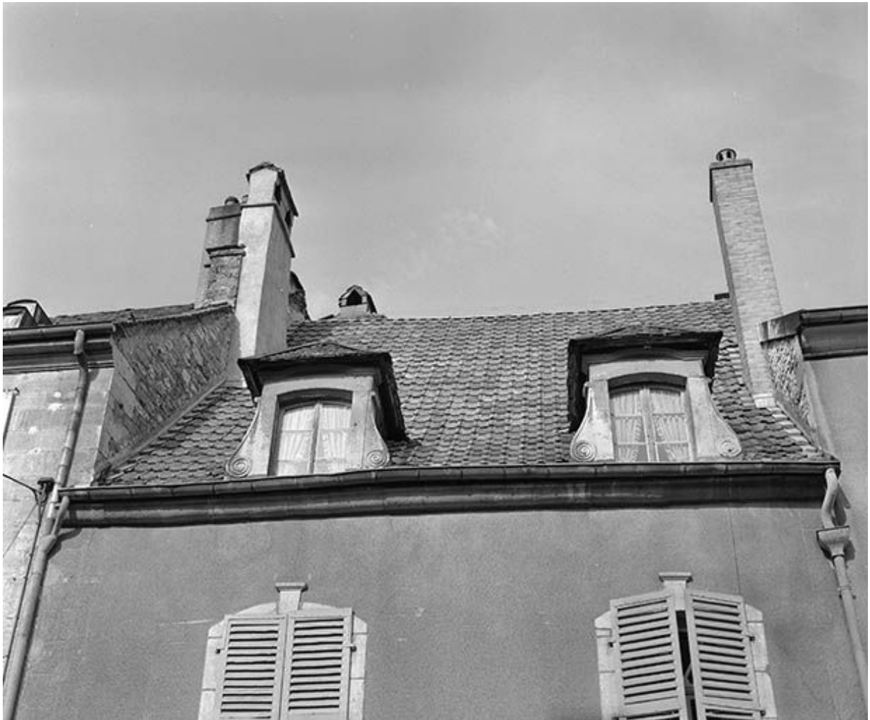
Maison (AE 74) 45 rue Pierre-Vernier : détail des baies de l'étage de comble.
