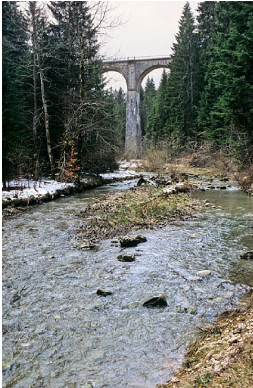
Viaduc : vue d'une pile, depuis le fond du vallon au nord-est.
