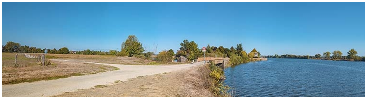
Le pont sur la Grosne et le port de Grosne, vus d'aval.
