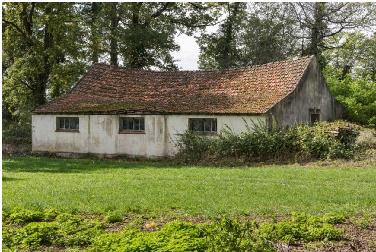
Etable : vue d'ensemble, depuis le nord-est.
