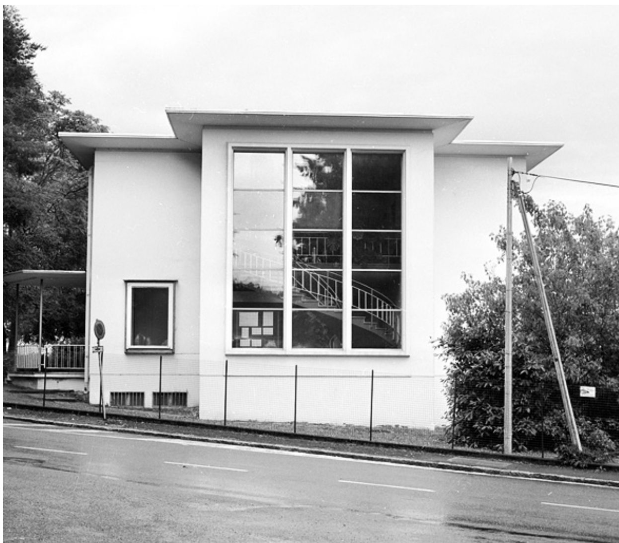
Façade nord du bâtiment administratif d'entreprise.
