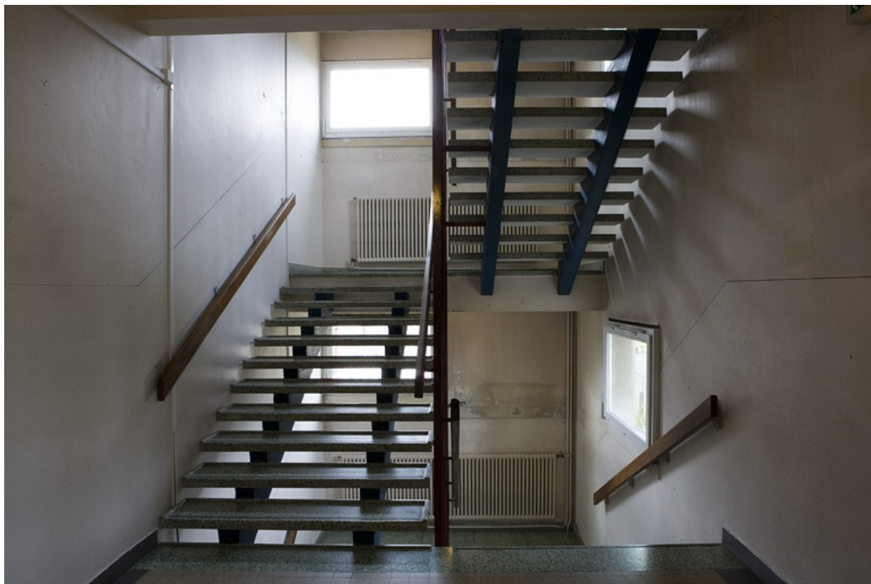
Bâtiment A. Intérieur: escalier.
