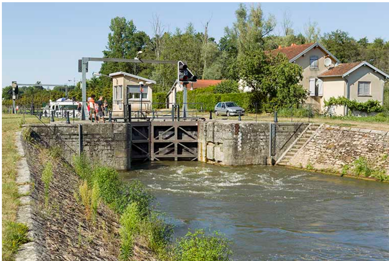
L'écluse depuis l'aval.
