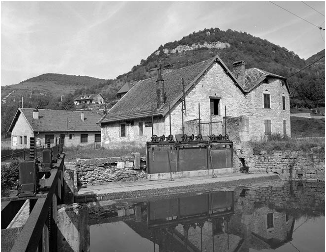
Vue d'ensemble depuis le barrage en 1980.
