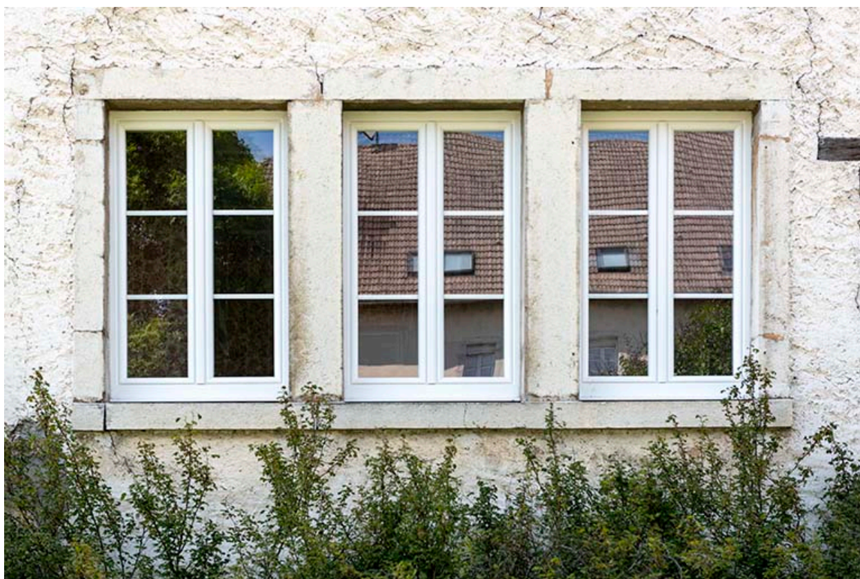
Façade latérale droite : fenêtres multiples.
