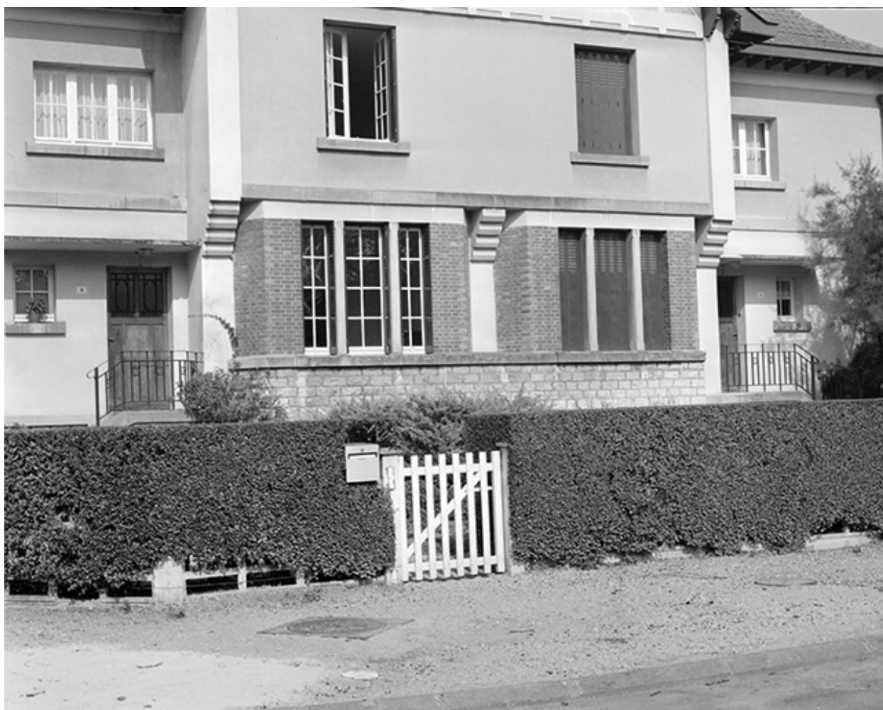
Détail du rez-de-chaussée de la façade antérieure.
