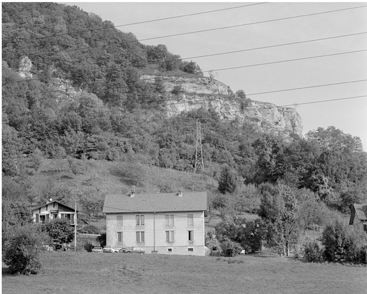
Logement ouvrier collectif depuis l'ouest.
