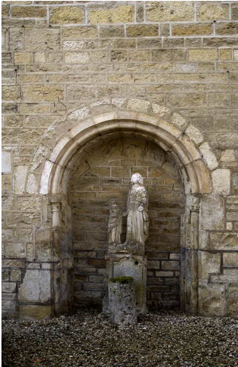
Bâtiment du réfectoire : détail du mur nord, porte d'accès au lavabo du cloître.
