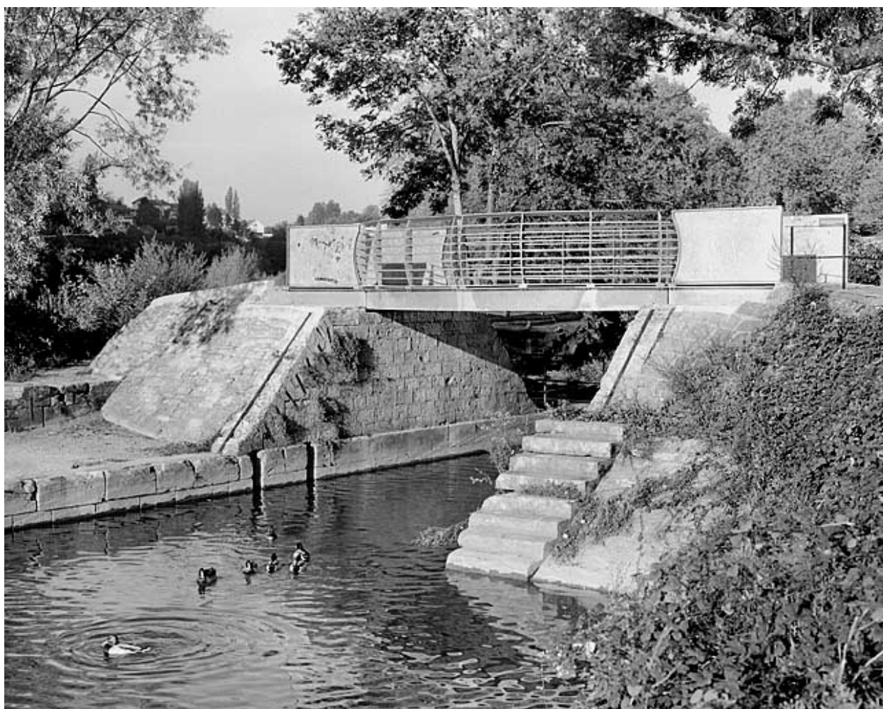
Passerelle de halage, depuis l'aval.
