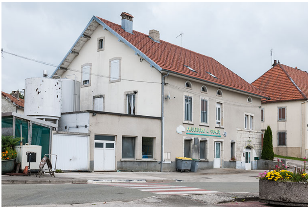
Vue depuis le sud-ouest.
