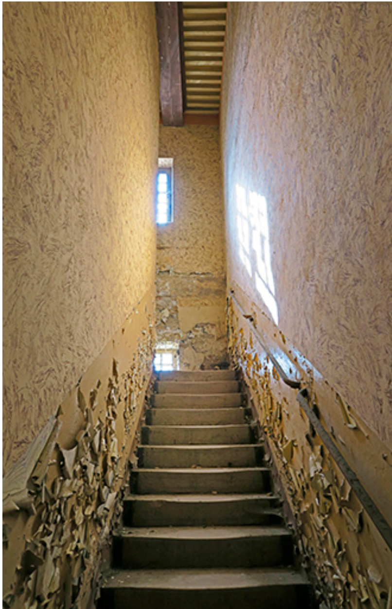
Première volée de l'escalier nord des prisonniers.
