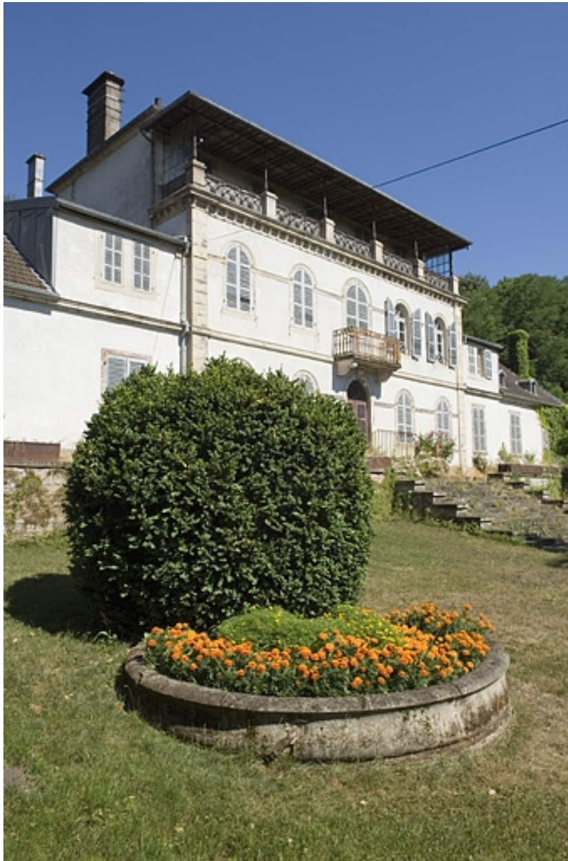
Logement patronal nord. Vue de trois quarts.
