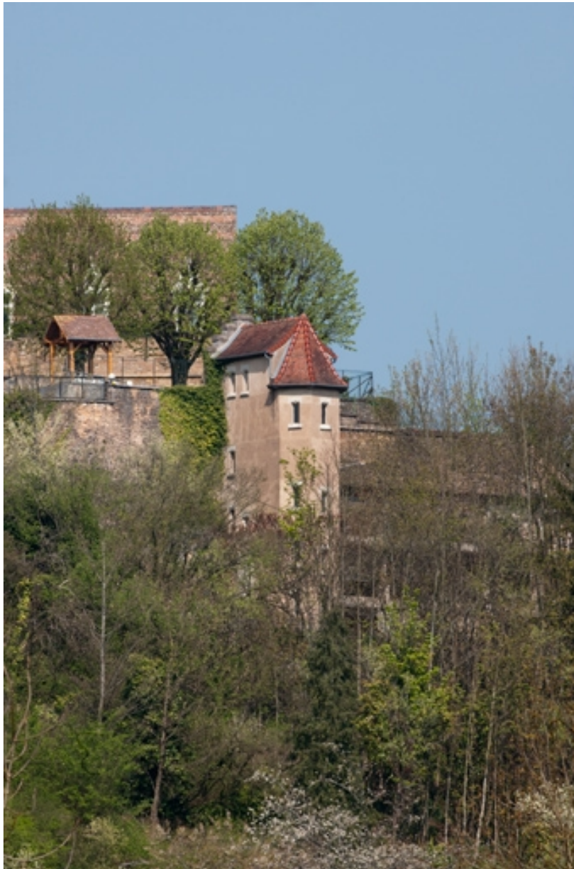
Bâtiment (H), tour d'escalier.
