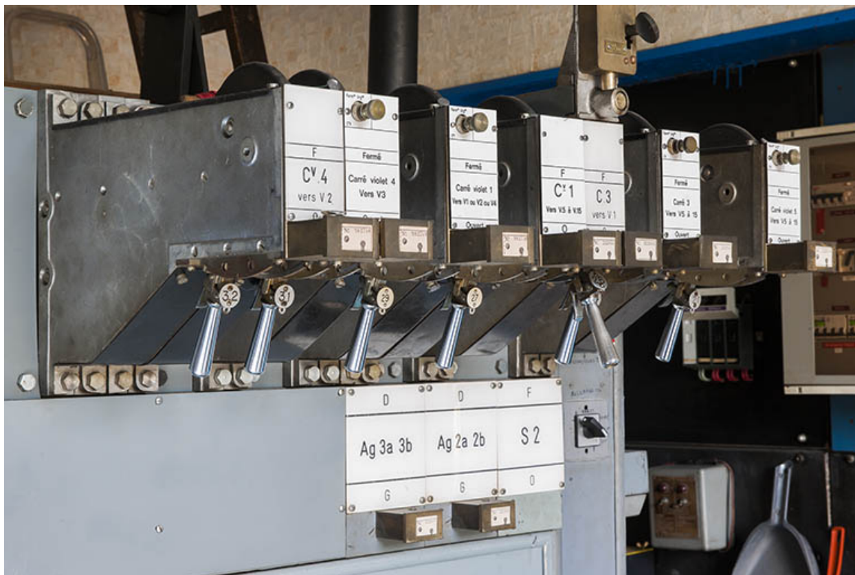
Gare de Port-d'Atelier, poste d'aiguillage : manettes de commande de la signalisation.
