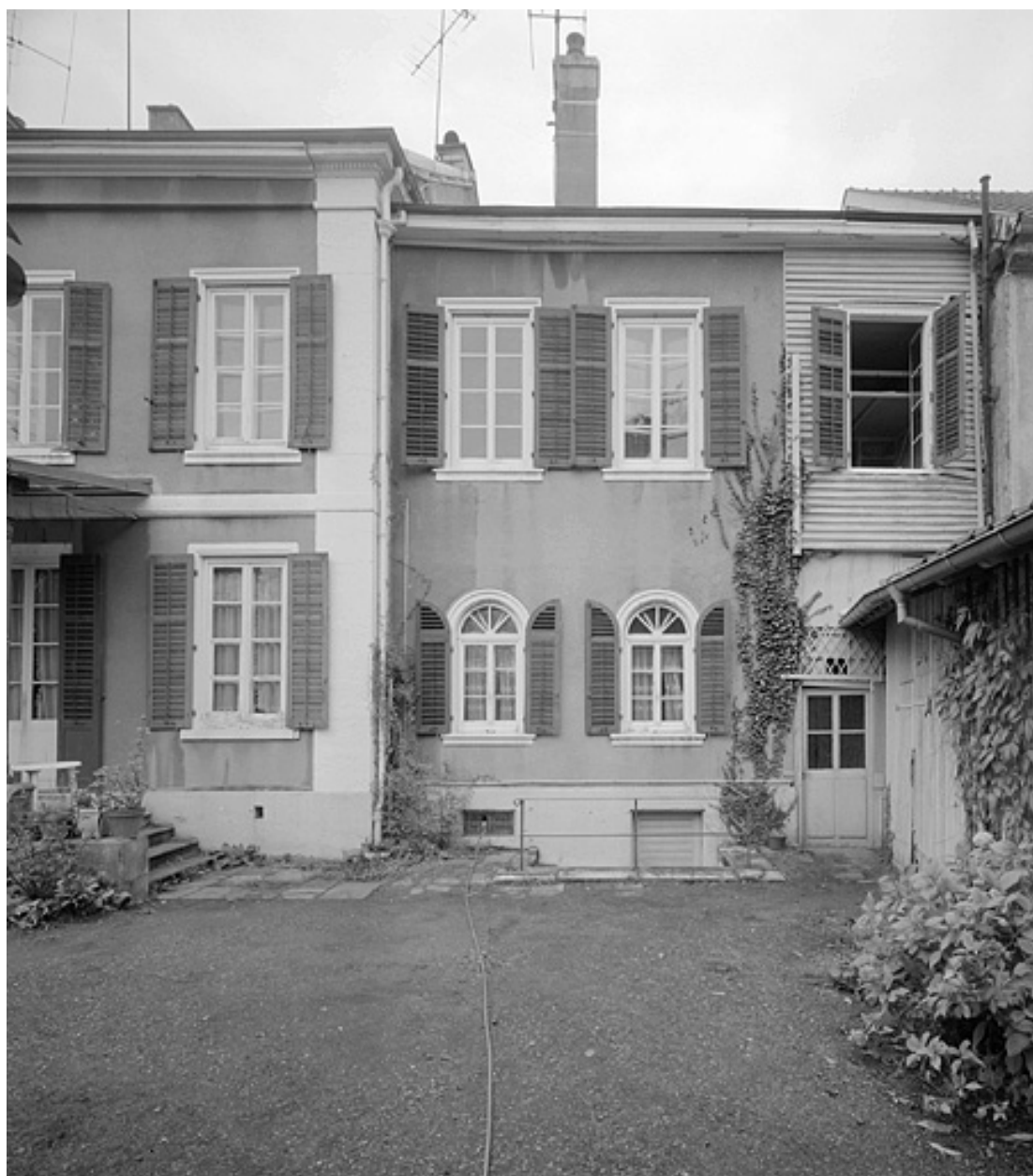
Façade sur jardin. Aile est.
