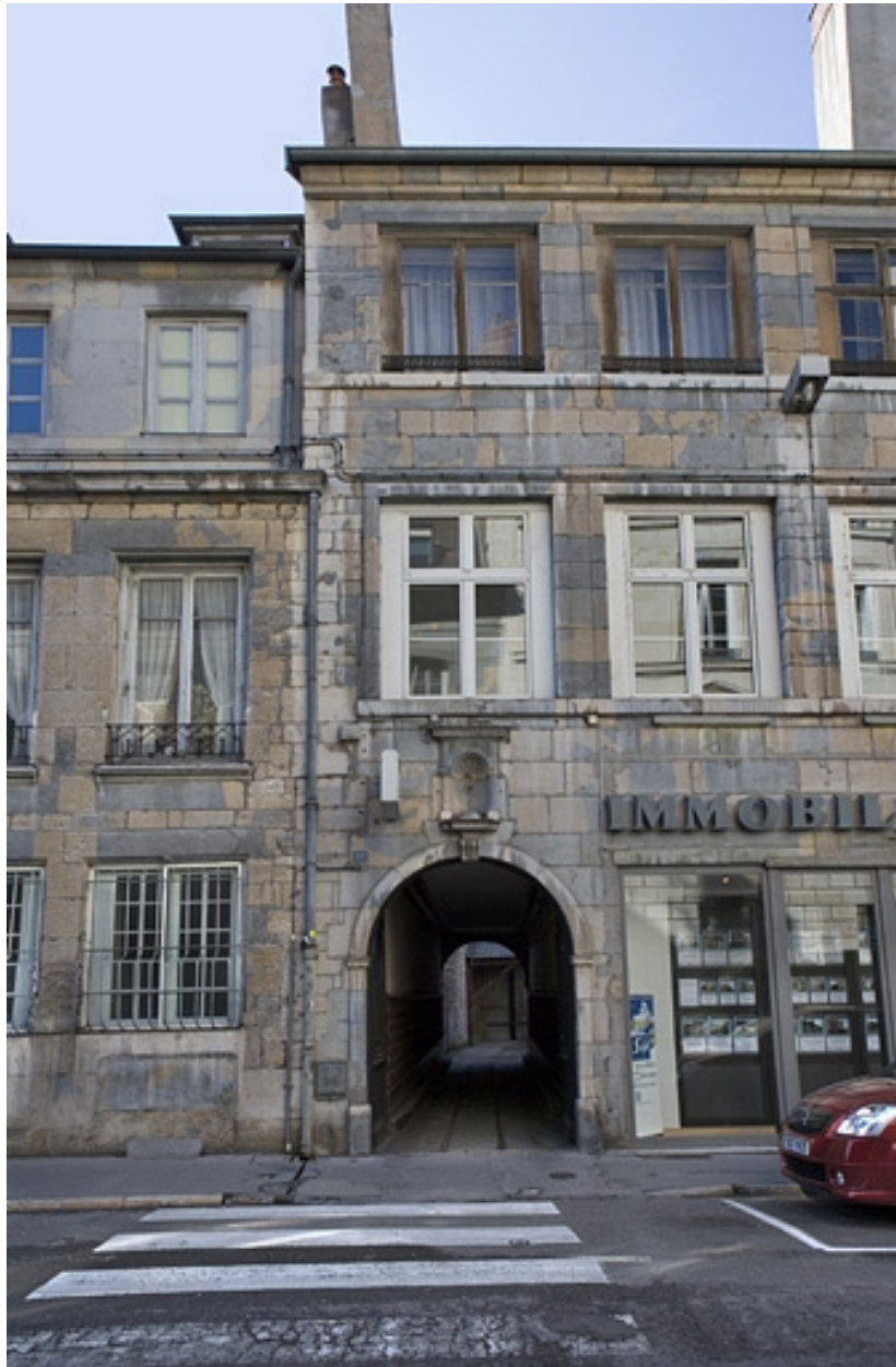
Détail du portail d'entrée.
