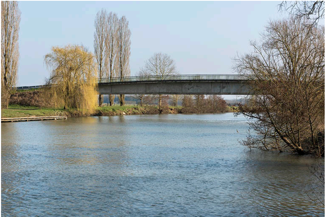
Franchissement de la Saône : pont de Fouchécourt.
