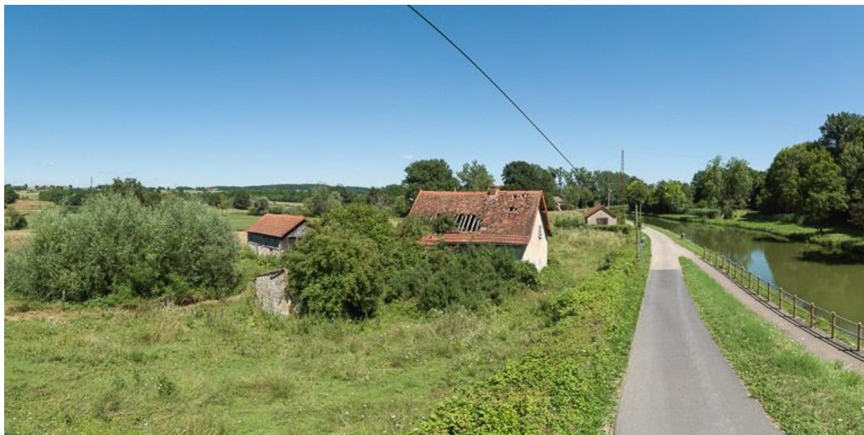
Le site vu d'aval.
