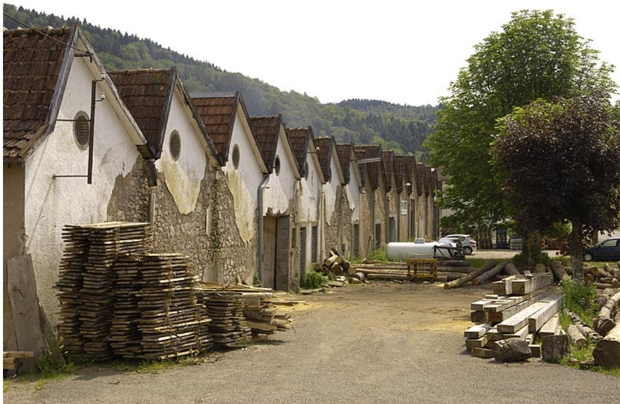
Pignons ouest de l'atelier de fabrication.
