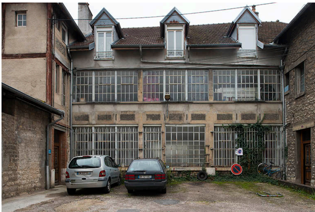
Façade nord d'un atelier de fabrication.
