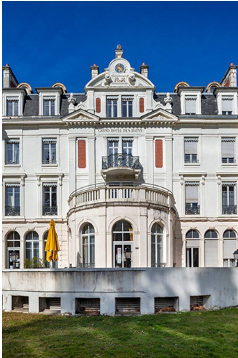
Façade sur le jardin, travées centrales.
