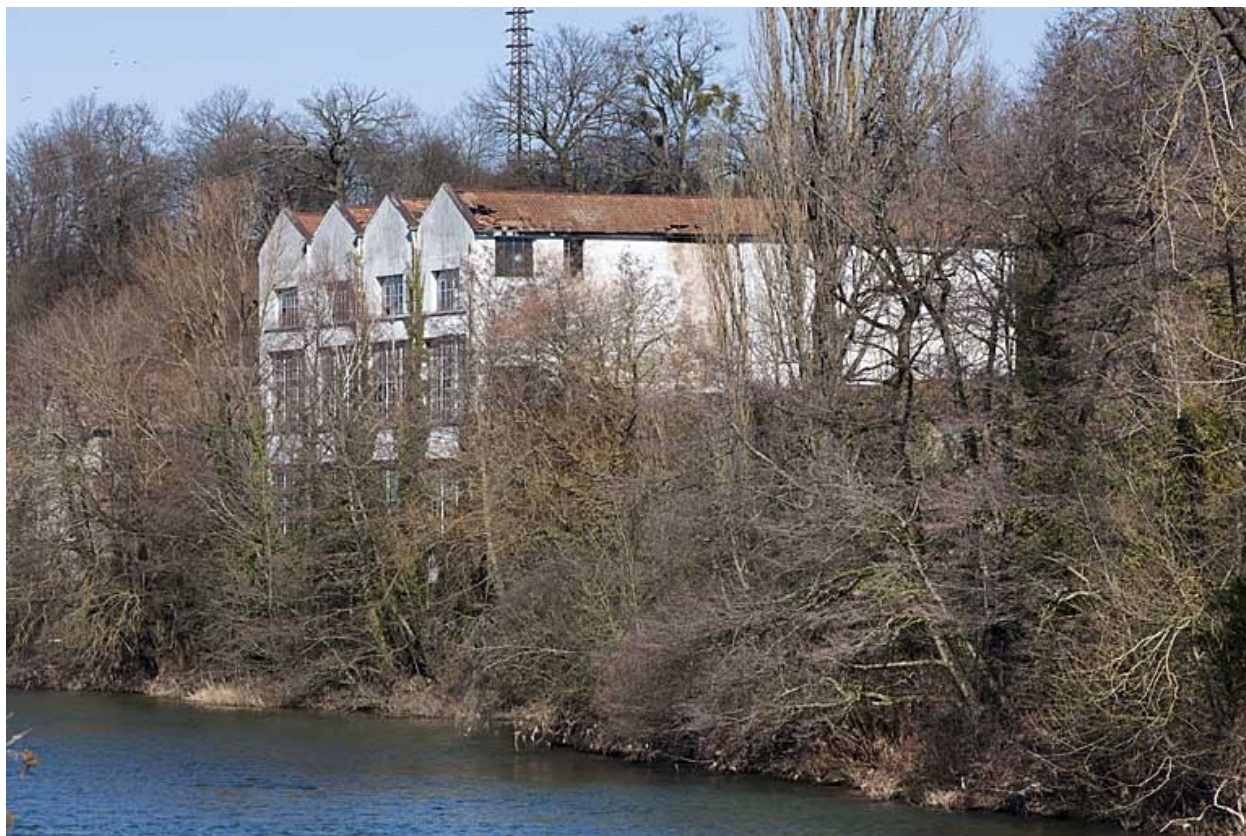
Atelier des presses depuis l'amont.
