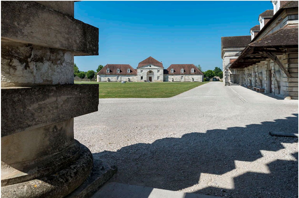
Saline d'Arc-et-Senans : logement des ouvriers et berne occidentale.
