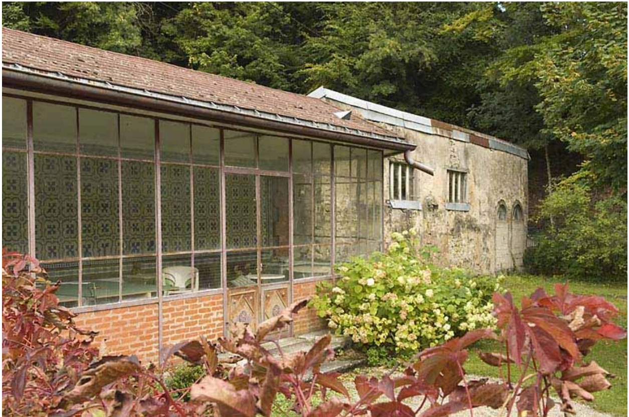
Serre et garage, vus de trois quarts.
