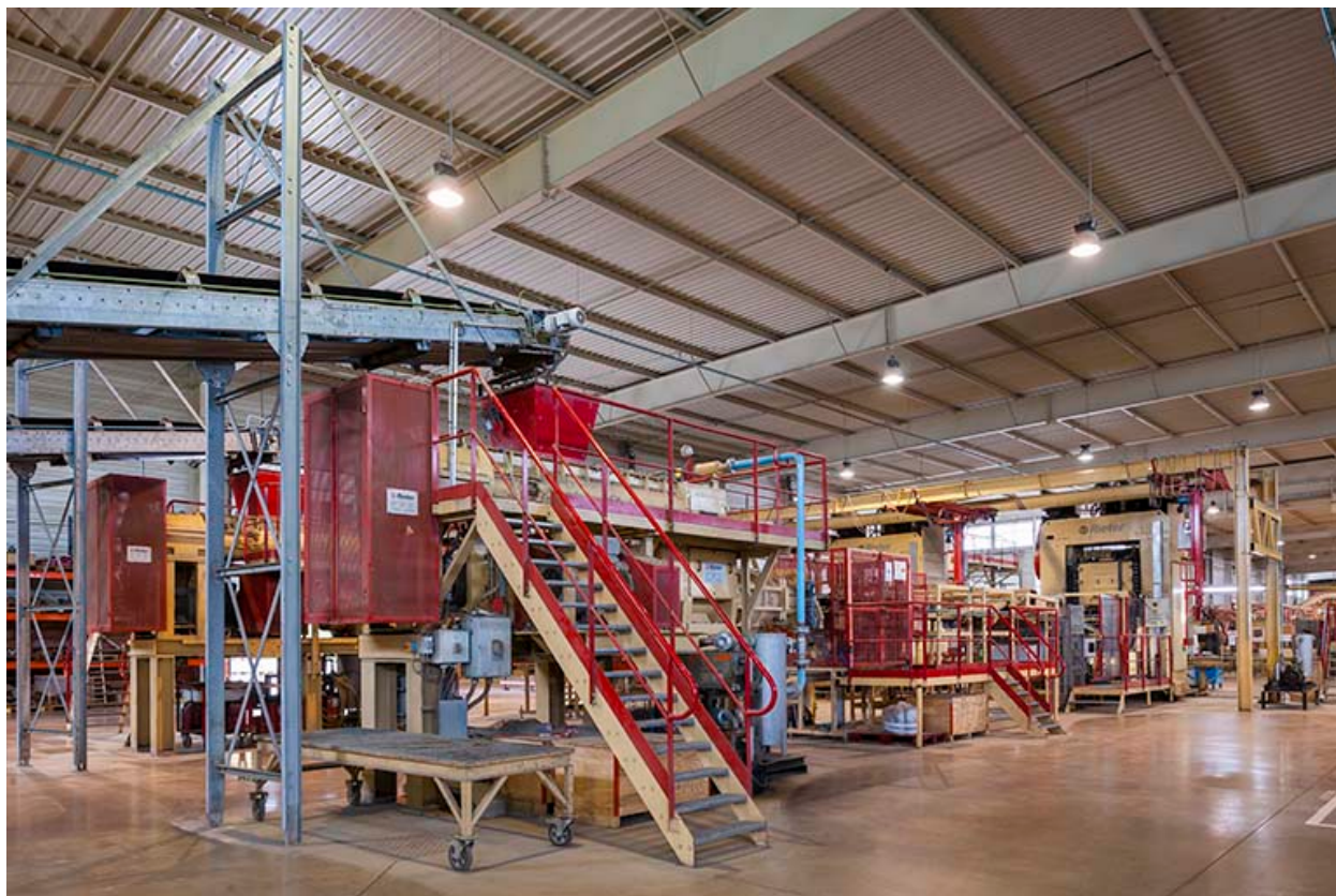
Unité de fabrication dite UL 5. Vue d'ensemble.
