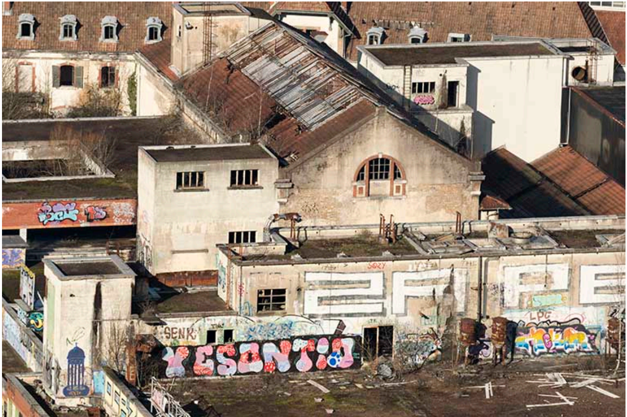
Etat en 2016. Usine A : vue plongeante sur l'arrière de la cantine.
