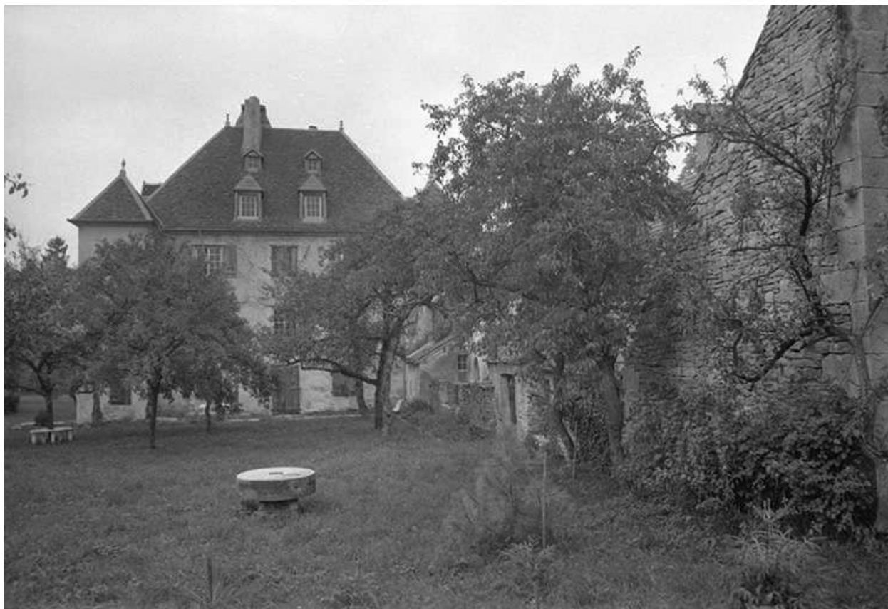
Face latérale droite vue depuis le parc.
