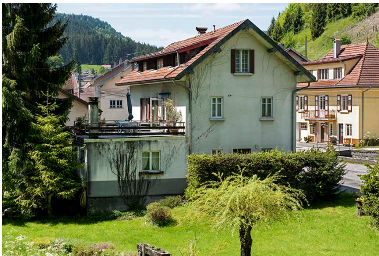
Façade postérieure et latérale gauche.
