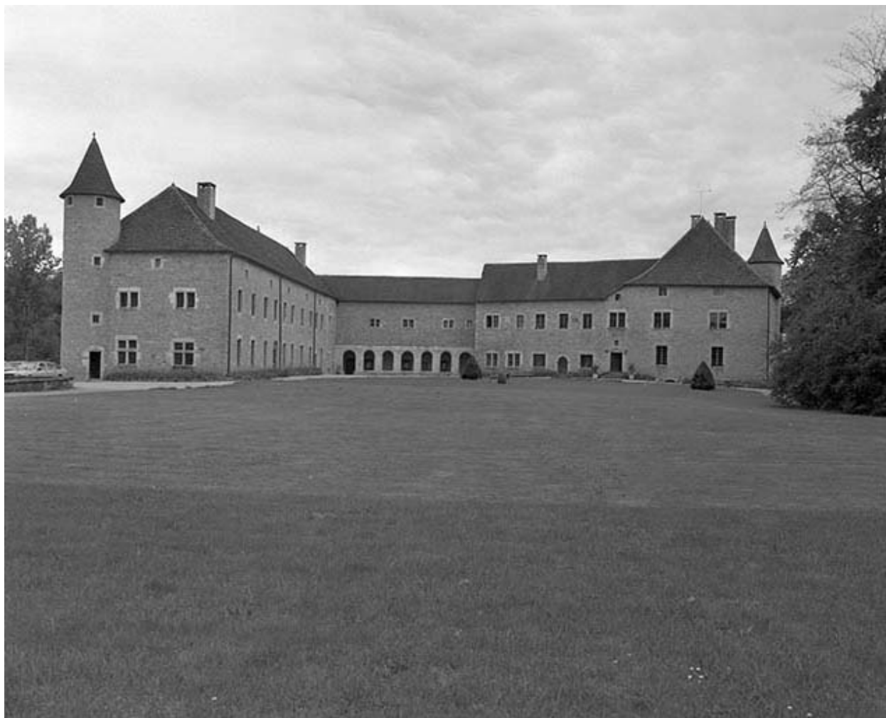
Façades sud et est.
