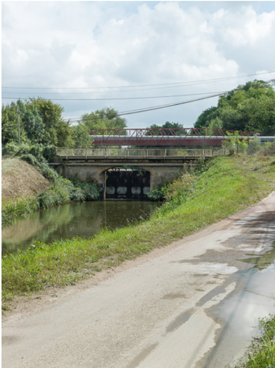
Vue d'ensemble du pont.
