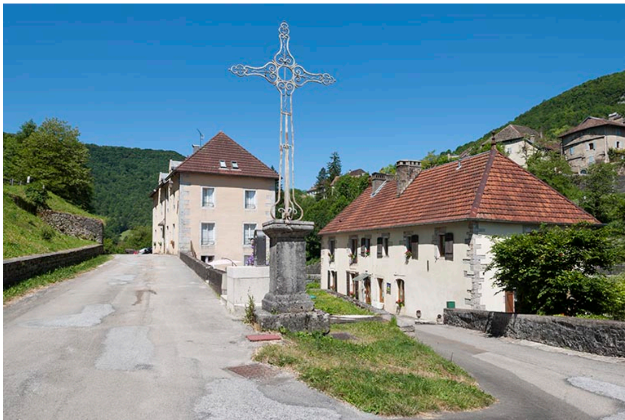
Logements d'ouvriers vus depuis l'est.
