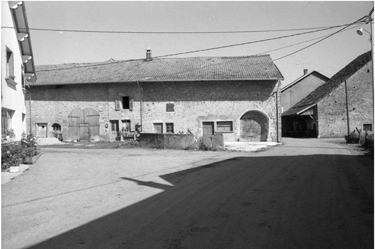
Ferme double située le long du chemin de grande communication n° 96 de Plasne à Mirebel.
