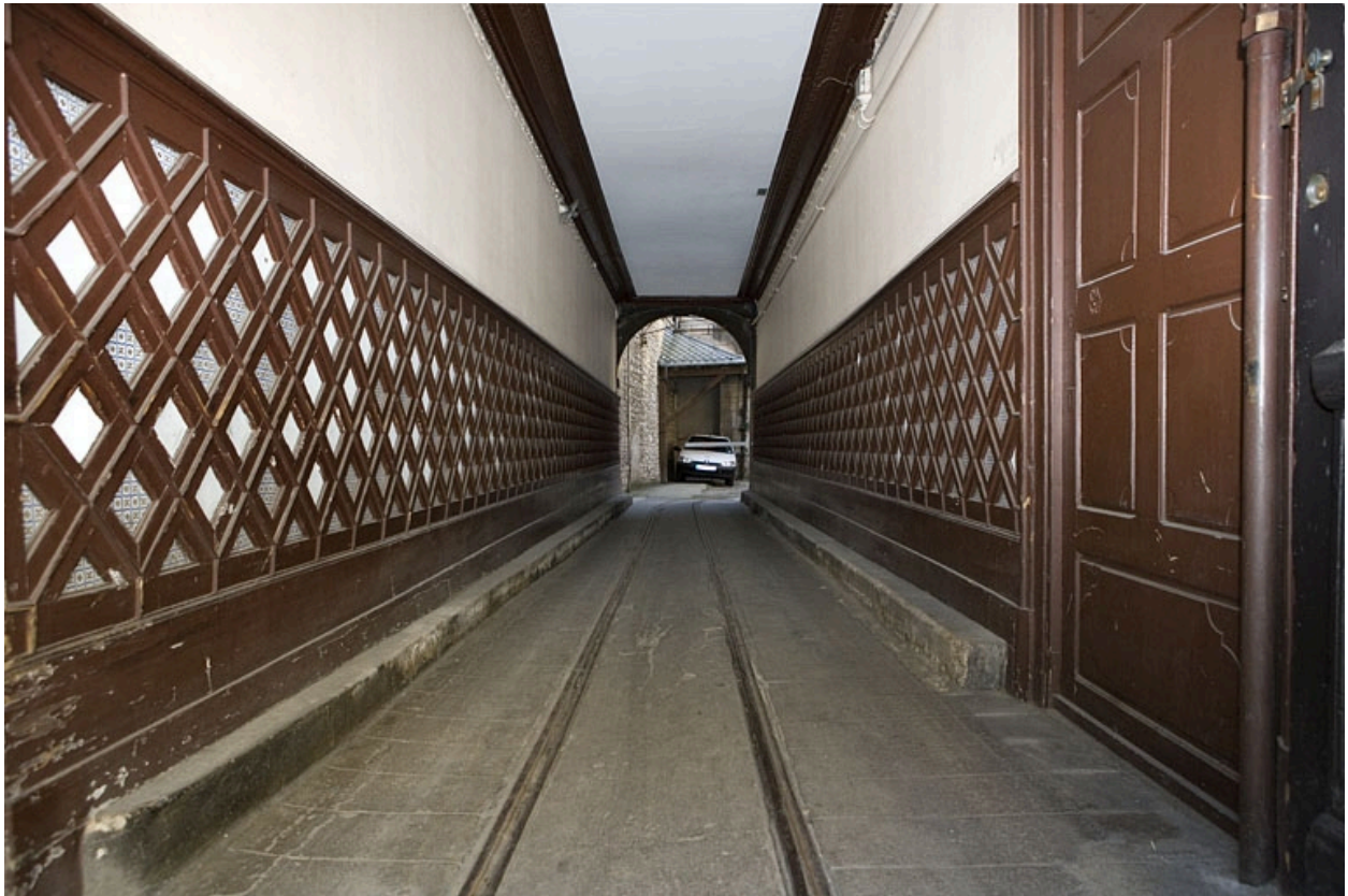
Vue d'ensemble du passage cocher depuis la rue avec la voie Decauville.
