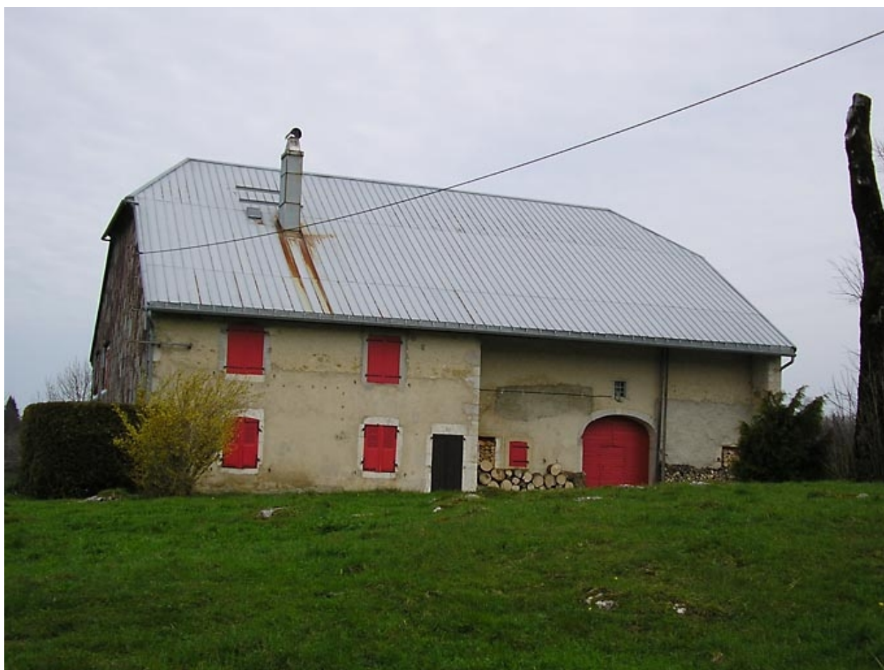
Vue générale de la façade postérieure.
