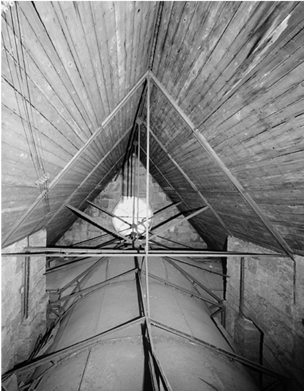
Charpente du transept.
