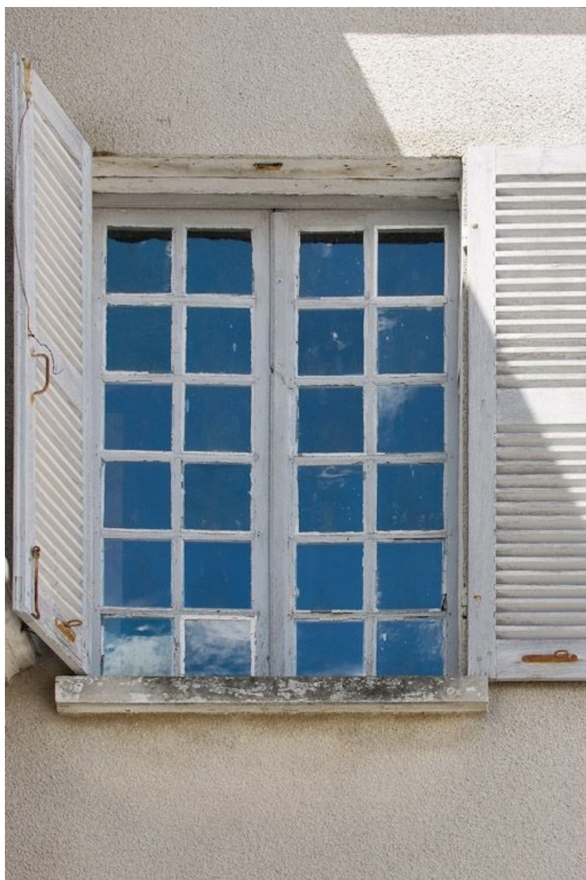
Bâtiment sud-ouest, détail d'une fenêtre.
