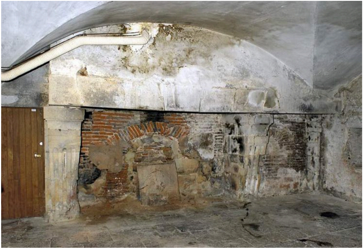
Ancien hôtel du gouverneur : sous-sol, cheminée.
