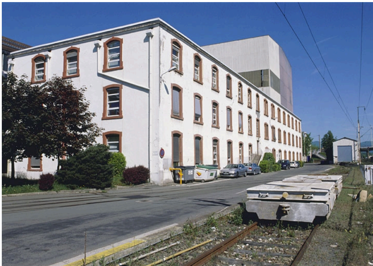
Vue de trois quarts de l'ancien centre d'apprentissage.
